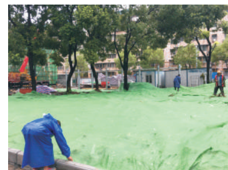
园林绿化工程防尘网覆盖
