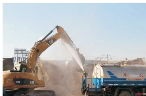
房屋拆除湿法作业
