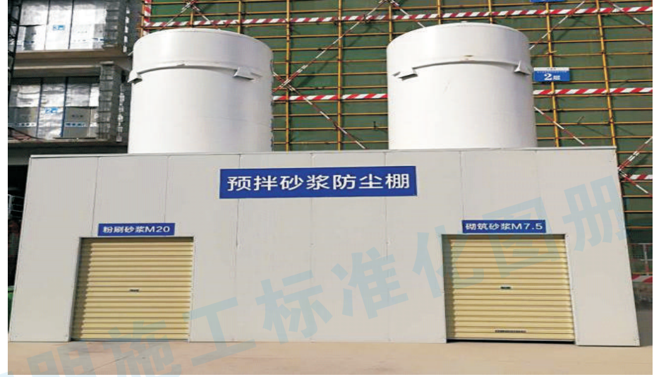
干粉砂浆采用砂浆罐储存
