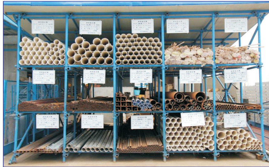
安装管材堆放区
