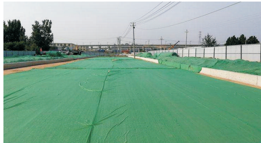
市政道路水稳层覆盖
