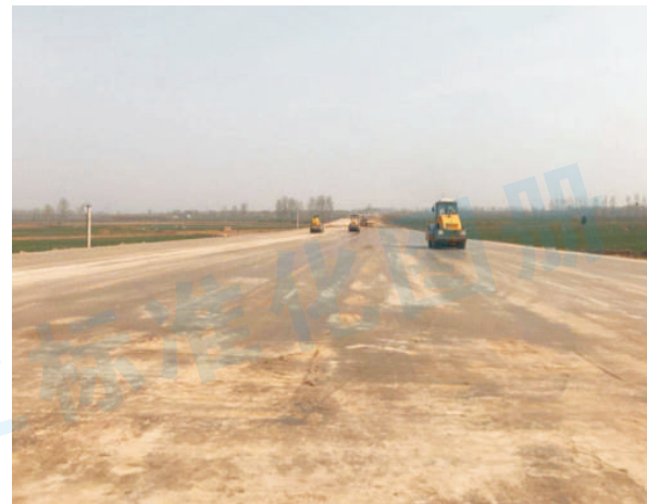
土路床湿润作业
