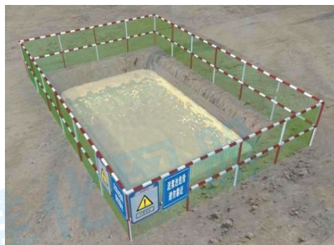
桩基施工泥浆池
