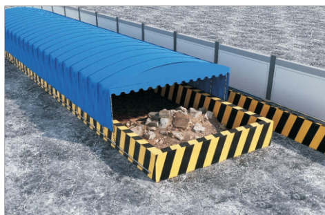
轨道交通盾构施工泥浆池
