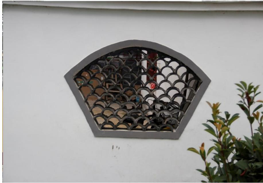
利用小青瓦进行重复的平面构成填充窗洞。
