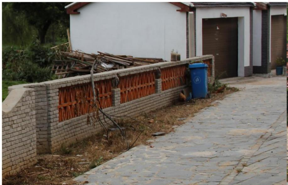
砌块水泥砖并将洞口填充红砖构成图案，能够体现出了设计的感觉。
