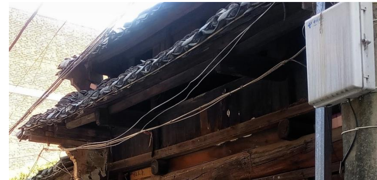
3 双坡檐——金口古镇
