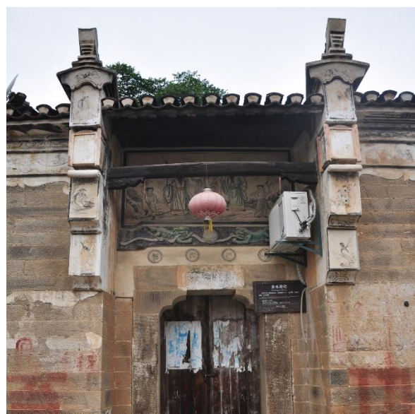
立面下部大块石材砌筑
