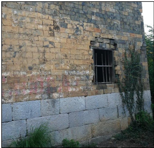
立面下部大块石材砌筑
