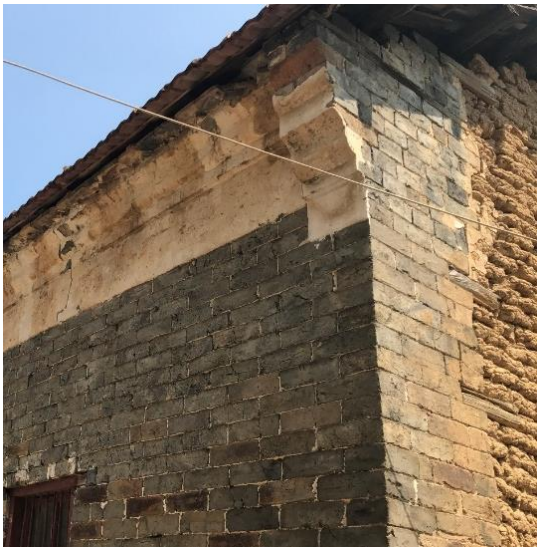
5 夯土山墙面——勤劳村
