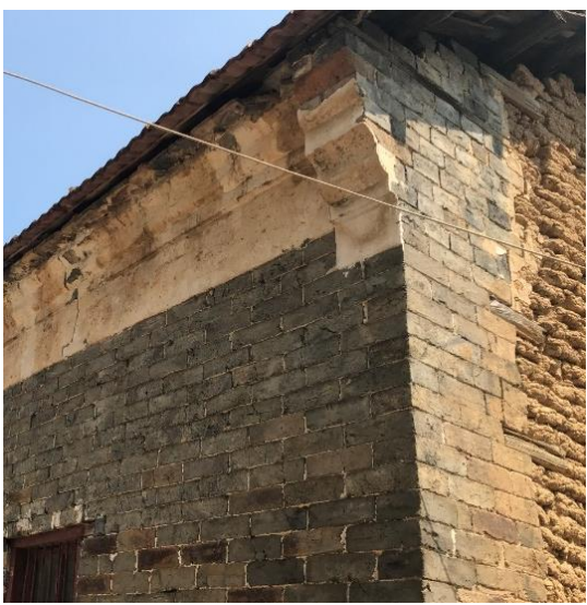
5 夯土山墙面——勤劳村
