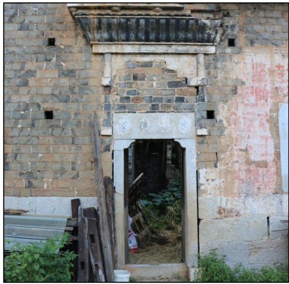
门洞为石框，门板为木门，前置两个石台
