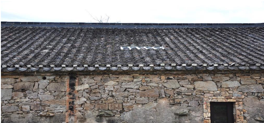
8 屋顶——杜堂村葛家湾
