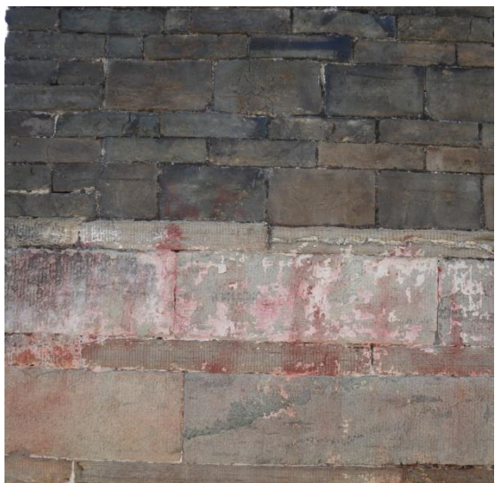
下段条石，上段青砖砌筑
